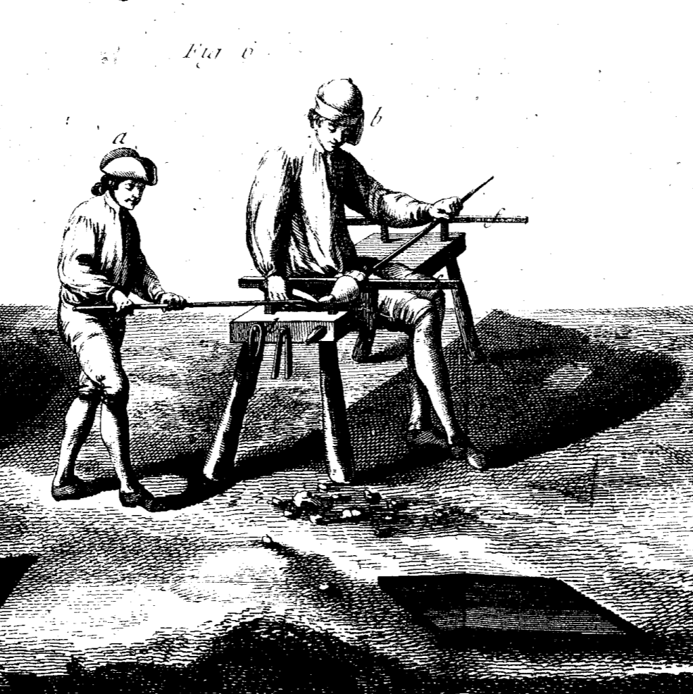
Verrerie en bois, l'opération de remuer la Composition dans le Pot de fonte, de cueillir la matiere ou Poste, de la rouler sur le marbre, de la souffler dans le moule, et autres opérations relatives à la façon d'un verre.
