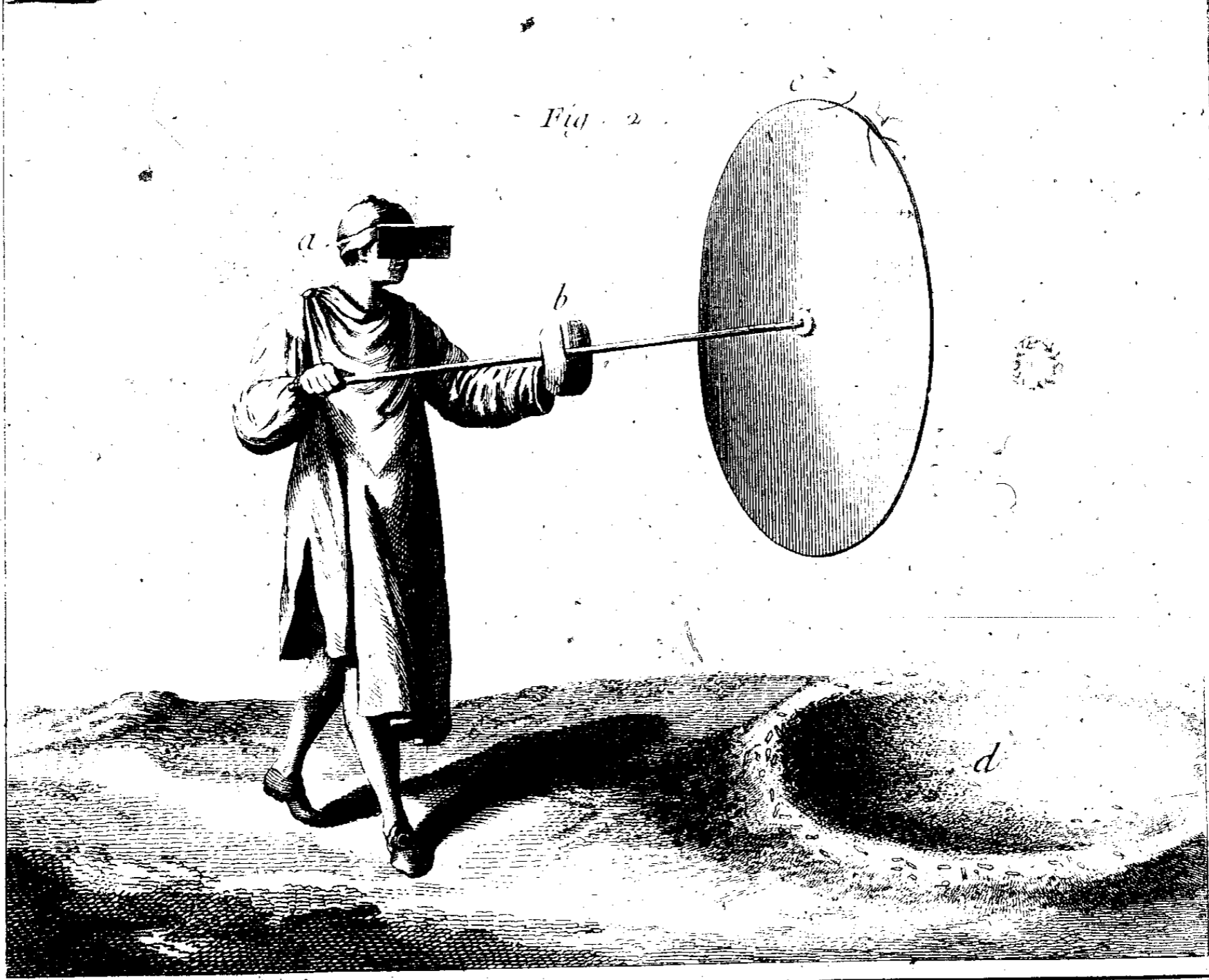
Verrerie en bois, l'opération de chauffer la Bosse pour l'ouvrir et en faire le Plat et le porter à la plotte.
