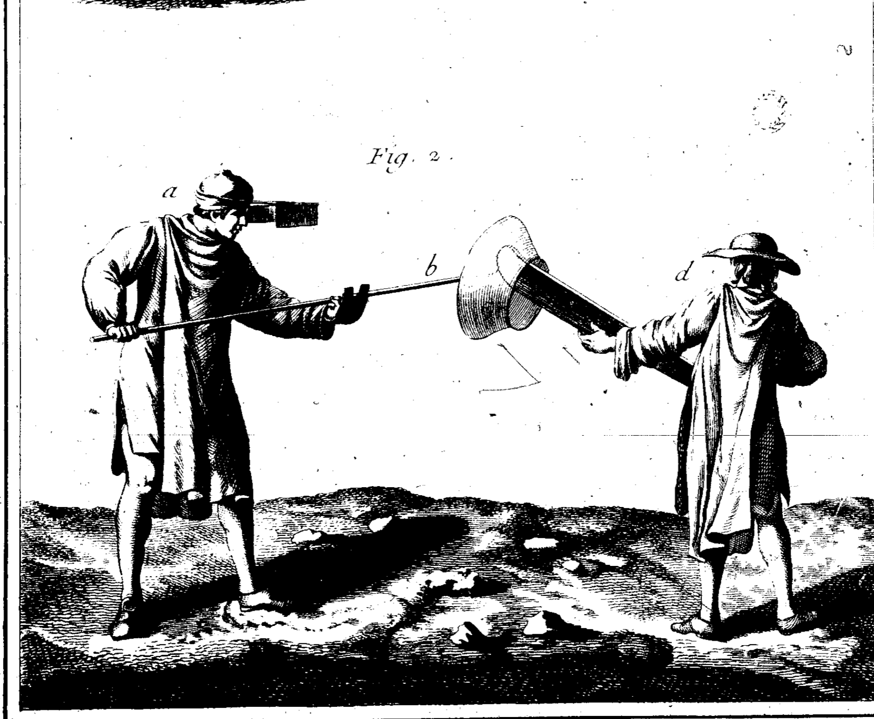
Verrerie en bois, l'Opération de Chauffer la Bosse et de l'abancher.
